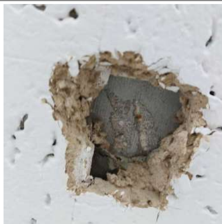
Prélèvement - P22 : R+4 / Bureau 410 - Enduit- (Présence d'amiante)
