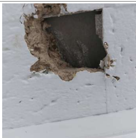
Prélèvement - P27 : R+3 / Open space - Plot de colle- (Présence d'amiante)
