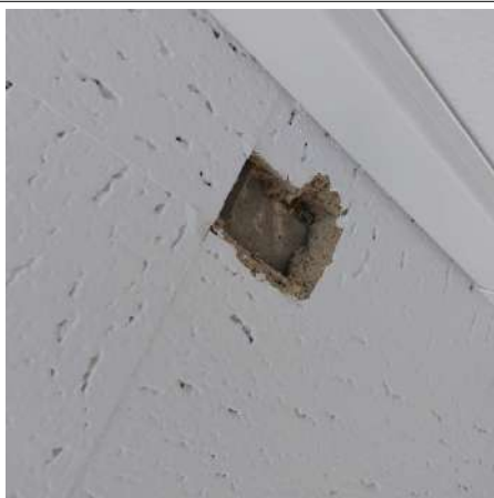
Prélèvement - P28 : R+3 / Open space - Enduit- (Absence d'amiante)
