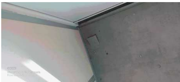
Prélèvement - P010 : R+4 / Bureau 47 - Ragraage, Colle- (Absence d'amiante)
