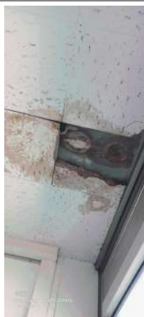
Prélèvement - P016 : R+4 / Bureau 47 - Panneau- (Absence d'amiante)
