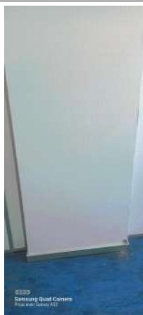
Prélèvement - P007 : R+3 / Bureau 2 à 4 - Enduit- (Absence d'amiante)
