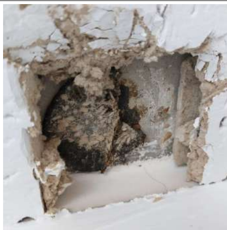
Prélèvement - P29 : R+3 / Box réception 1 - Plot de colle- (Absence d'amiante)
