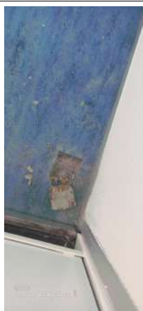
Prélèvement - P003 : R+3 / Bureau 2 à 4 - Ragréage, Colle- (Présence d'amiante)
